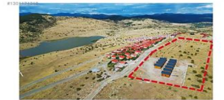
ANKARA BEYPAZARI KARAŞAR KARTALTEPE VİLLA PROJESİ 1.ETAP dan OLUŞMAKTA 1 ETAP TAMAMLANDI TOPLAM 40 ADET VİLLA YAPILACAK
